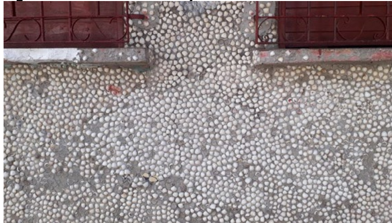
Figura 19: Conchas usadas para revestimento de fachada.
