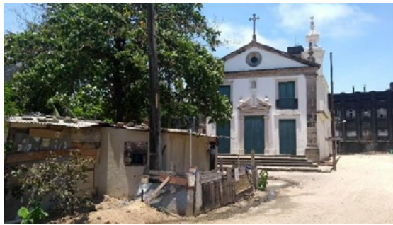
Figura 13 – Comunidade do Pilar.
