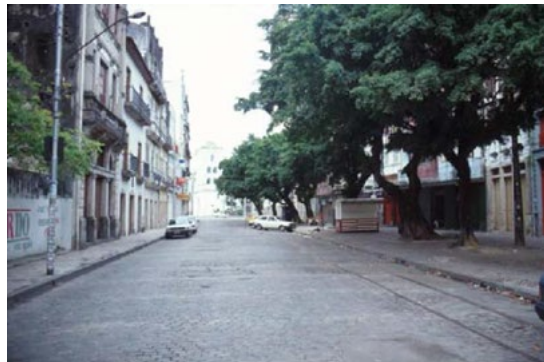
Figura 2 – Rua do Bom Jesus antes da intervenção.
