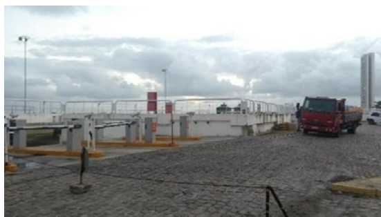
Figura 8 – Estacionamento construído na foz do rio.
