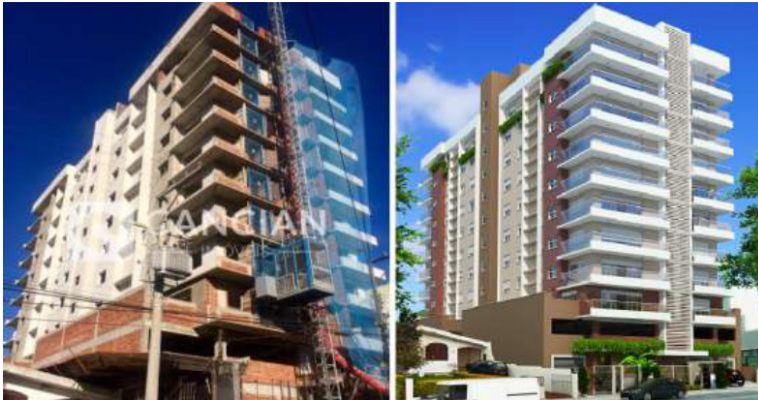
Figura 2: Edificação em construção e simulação do projeto concluído
