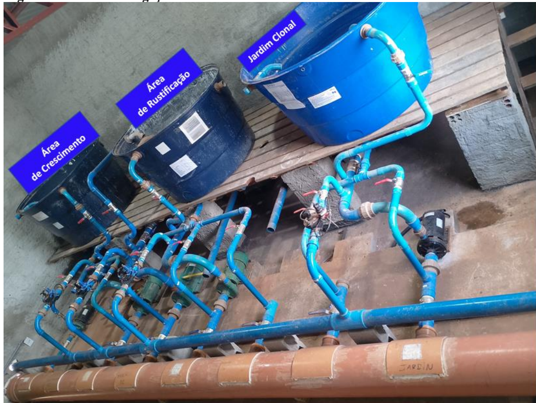
Figura 11 – Casa de irrigação atual
