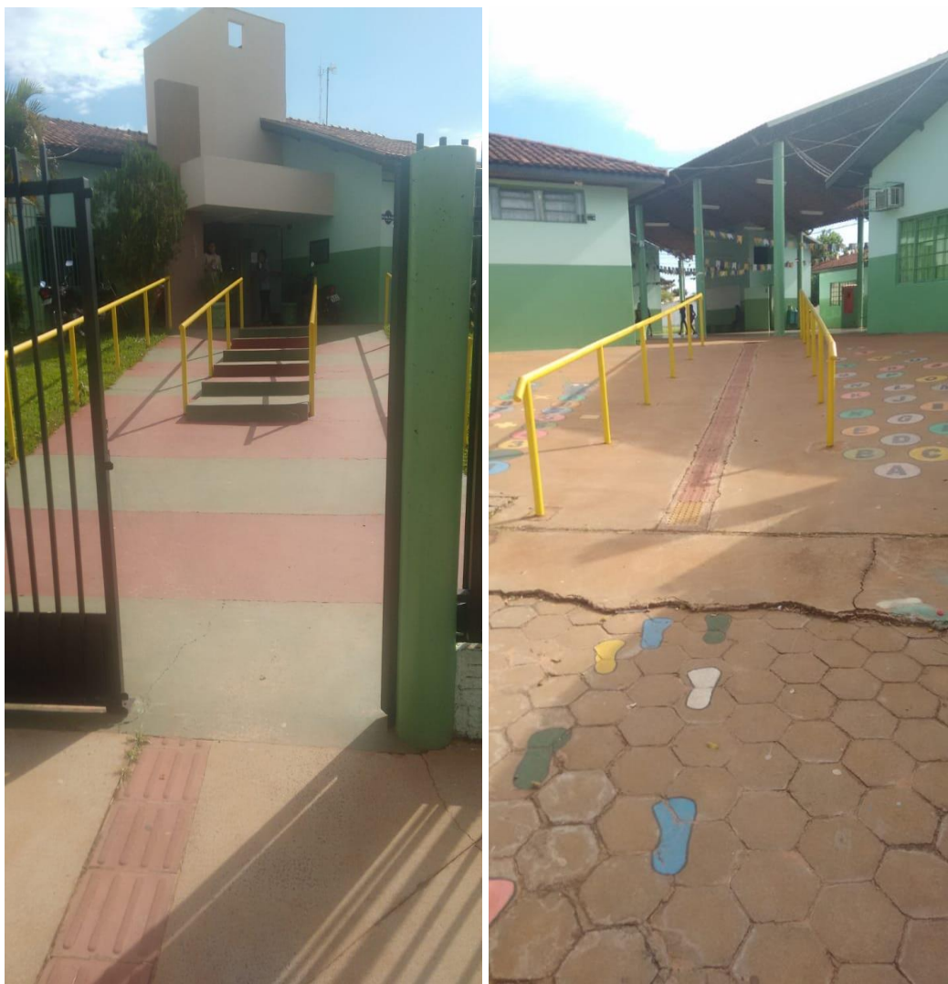
Figura 1: Entrada da escola com acessibilidade
