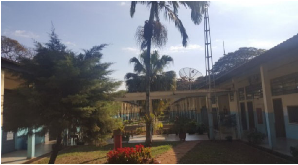
Figura 2: Foto do prédio da Escola Estadual Orlando Quagliato Fonte: arquivo pessoal do autor
