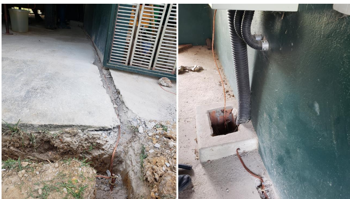
Figura 11: Conexão da malha de terra ao QDG
