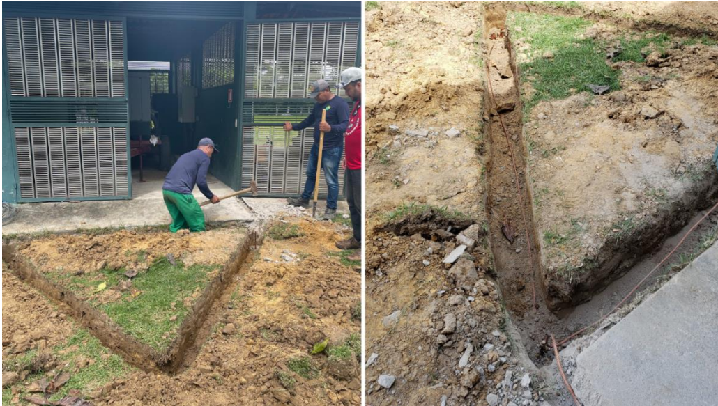
Figura 9: Escavação e implementação da malha de aterramento
