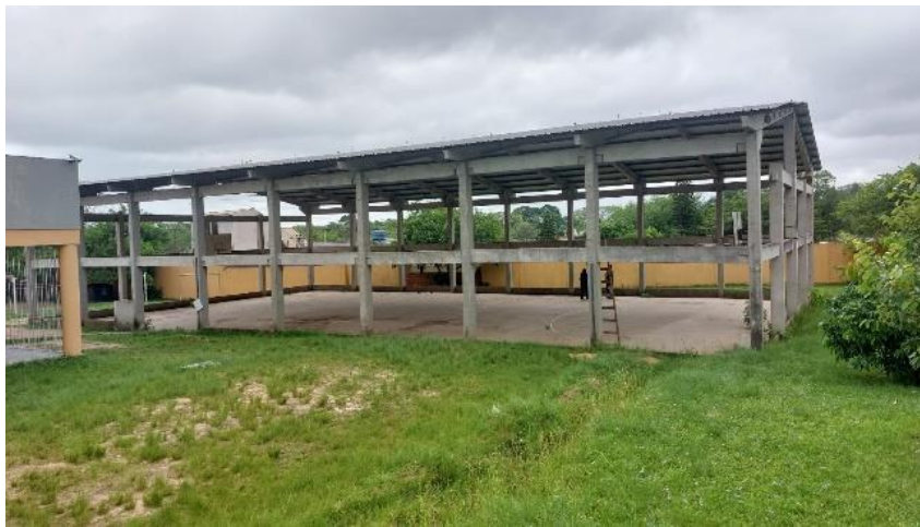
Figura 5. Quadra poliesportiva coberta
