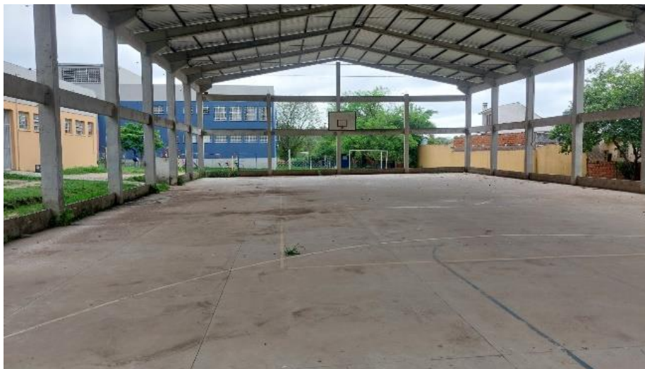
Figura 6. Quadra poliesportiva coberta
