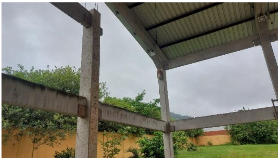
Figura 7. Viga de concreto armado do cintamento superior caída
