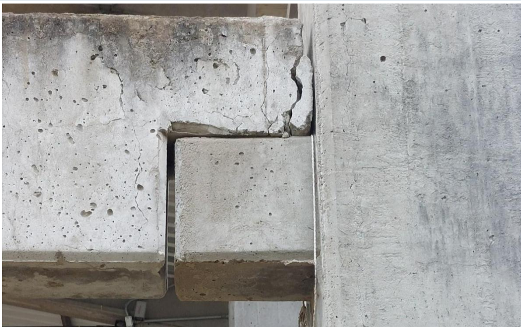
Figura 15. Danos no dente da viga por falha de montagem
