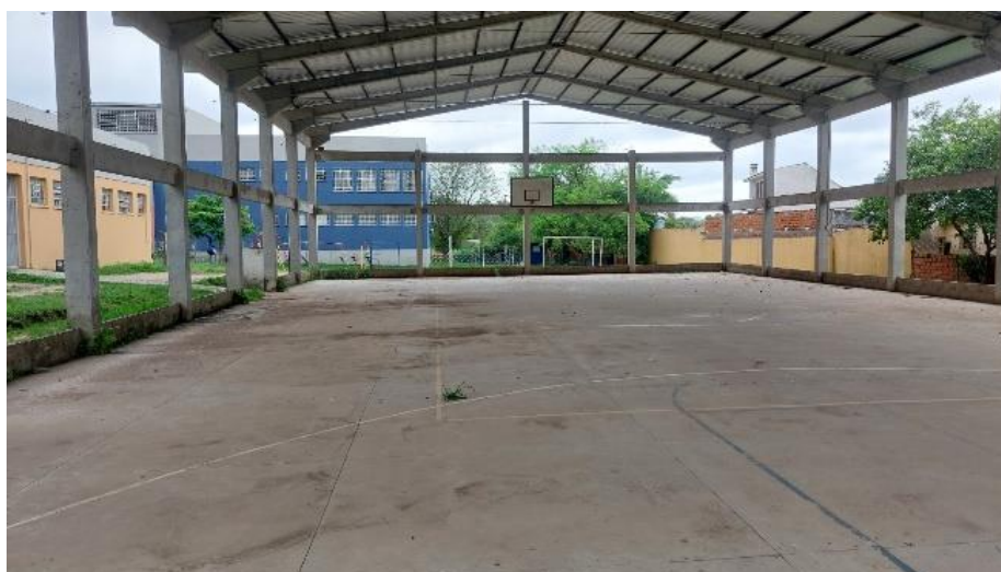
Figura 6. Quadra poliesportiva coberta
