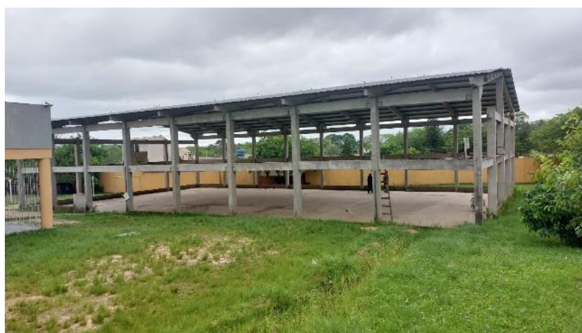
Figura 5. Quadra poliesportiva coberta
