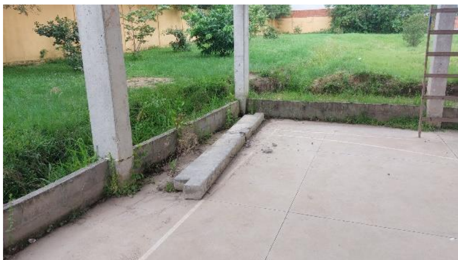
Figura 8. Viga de concreto armado do cintamento superior caída
