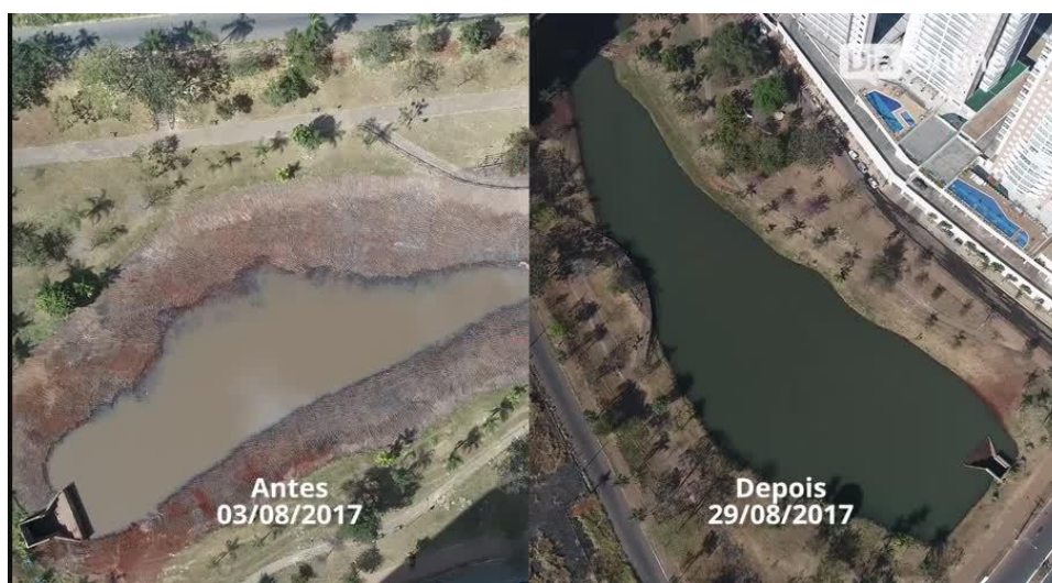
Figura 8: Obras de recuperação e revitalização do lago do Parque Cascavel.
