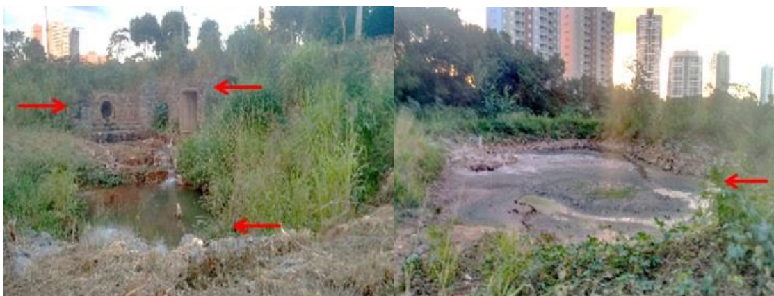
Figura 9: Infraestrutura com manilha, galeria e bacia de contenção no alto curso do Córrego Cascavel. Fonte: Ana Maria Camargo de Vicente (2017).
