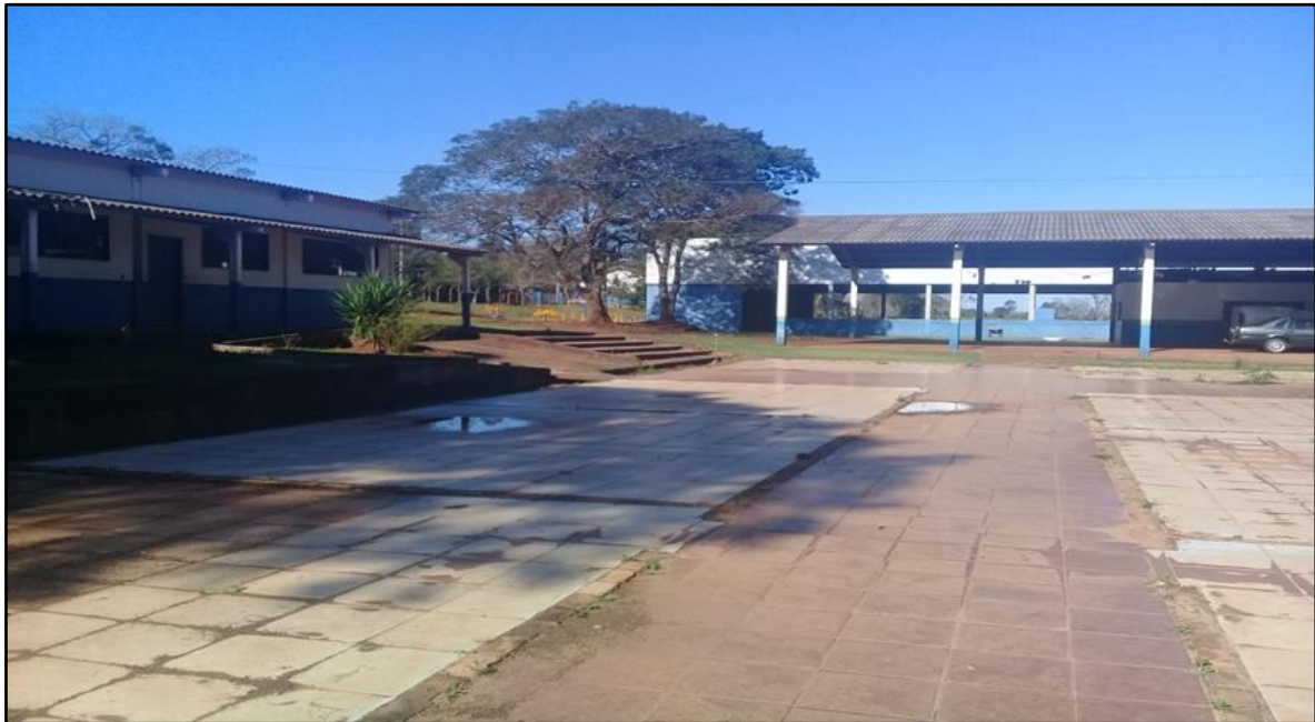
Figura 3 - Estrutura atual da antiga EM Santa Rosa.
