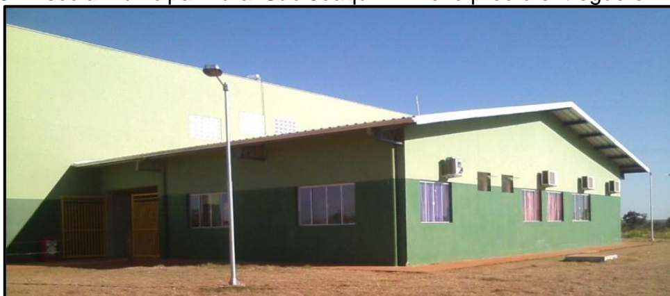
Figura 03 - Escola Municipal Rural São Joaquim - Novo prédio entregue em 2015
