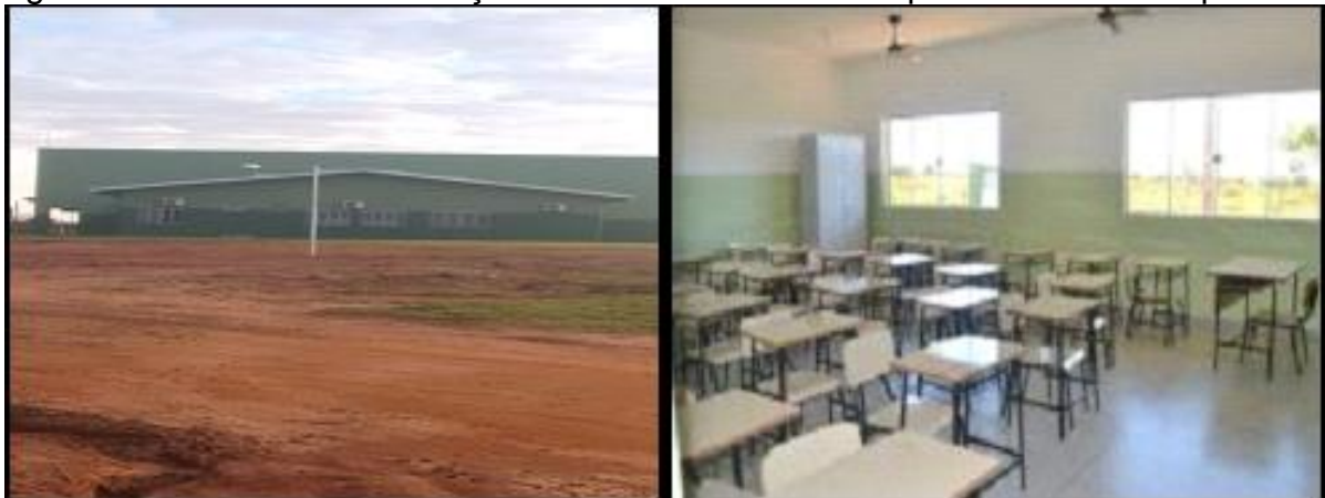
Figura 2 – Selvíria/MS: instalações da nova Escola Municipal Rural São Joaquim
