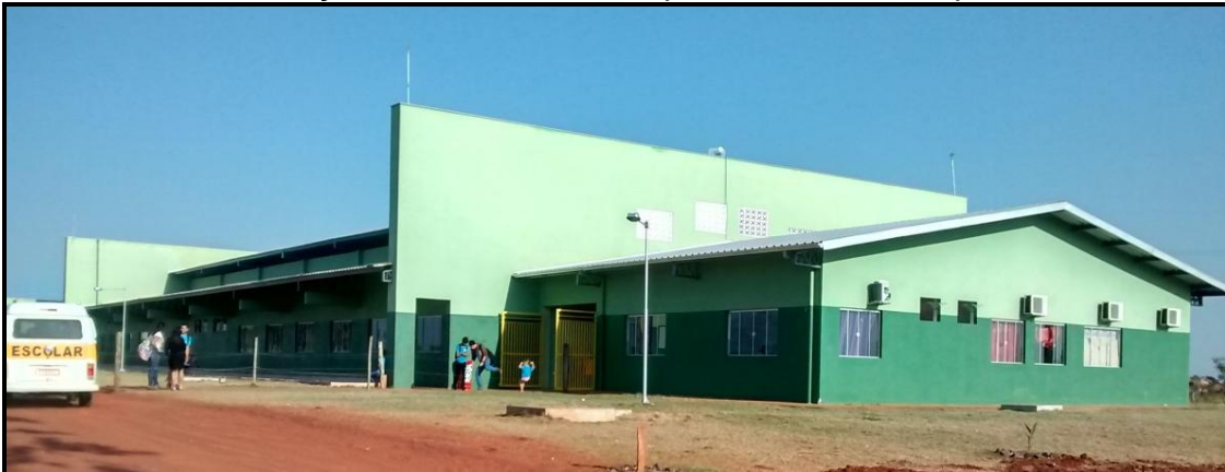
Figura 2: Novas Instalações da Escola Municipal Rural São Joaquim
