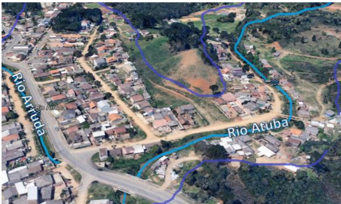
Figura 13 – Áreas urbanizadas em áreas de inundação no jardim Cesar Augusto – bairro Roça Grande. A esquerda existe áreas de urbanização consolidada na área de inundação do rio Arruda. A direita área de urbanização intermediária implantada entre 2000 e 2017 na área de inundação do rio Atuba. Azul marinho = área de inundação. Azul claro = rios. Fonte: Imagem do acervo Google Earth (2017). Org.: Os autores (2020).
