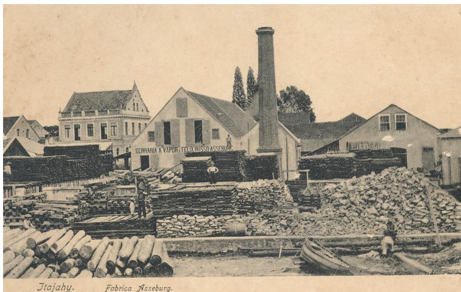
Figura 1 – Cartão postal com vista da serraria a vapor Asseburg em 1907
