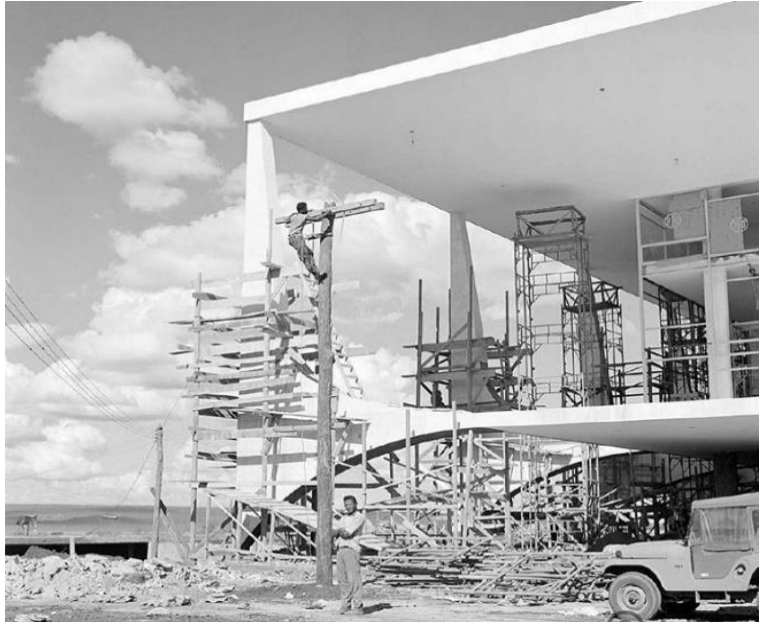
Figura 8: Fotografia (autor desconhecido) que registra a construção do Palácio do Planalto.
