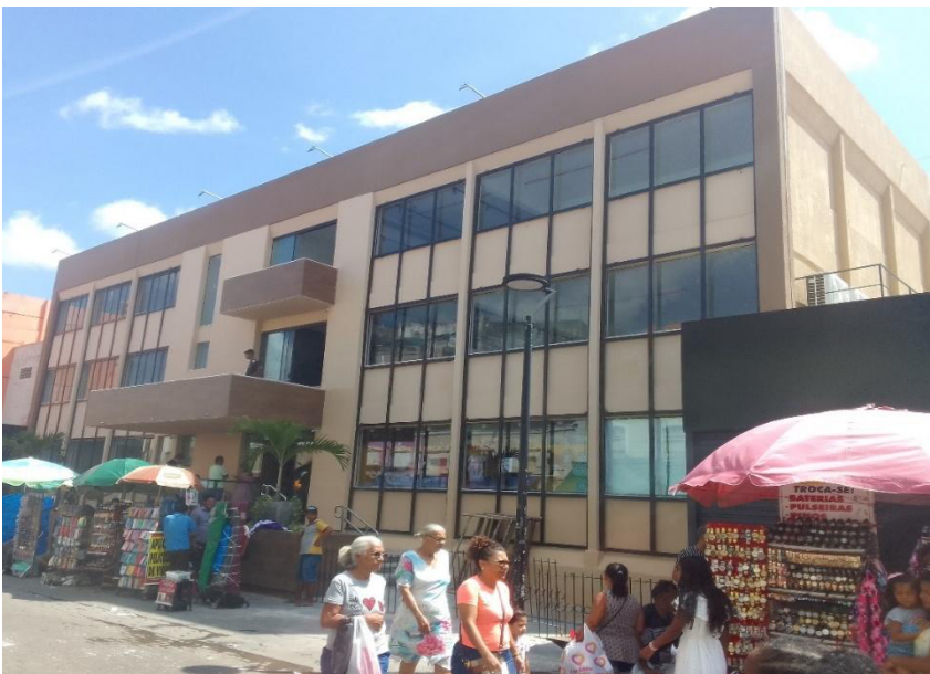
Fachada del Shopping Rua Grande
