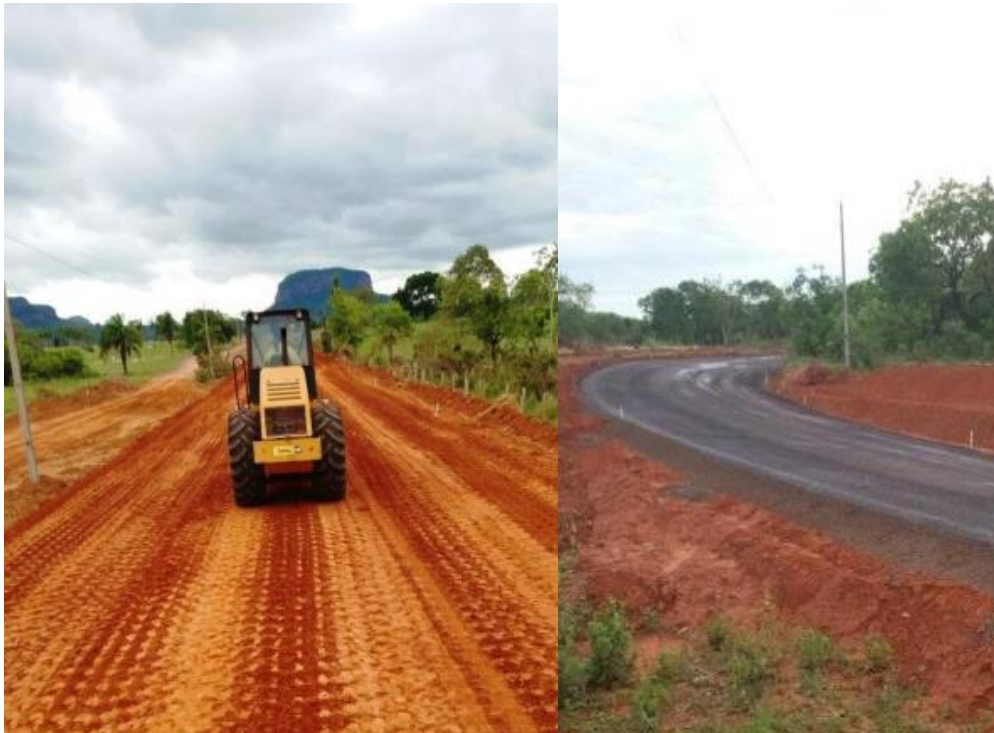
Figura 06: Visão do trecho em asfaltamento na Estrada Parque
