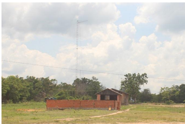
Imagem 09: Início da obra de uma casa de alvenaria. Foto: O autor (2016).
