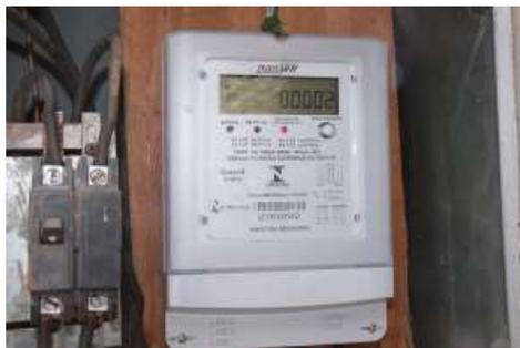
*Novo medidor de energia que alimenta a rede com energia gerada a partir do sol*
