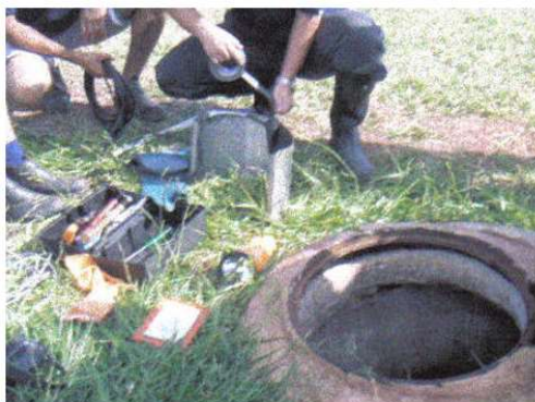
Figura 4: Instalação do medidor de esgoto através do poço de visita.
