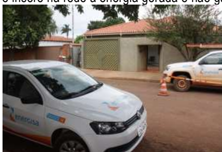
Equipe da Energisa liga o padrão reversor na primeira residência urbana de Chapadão do Sul
