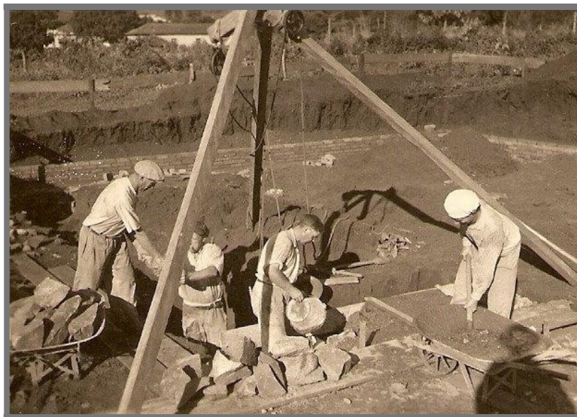
Figura 1 - Fundação da Igreja - Freis trabalhando na edificação.
