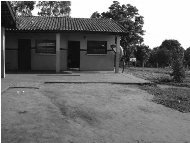
Figura 04 - Vista lateral da escola.
