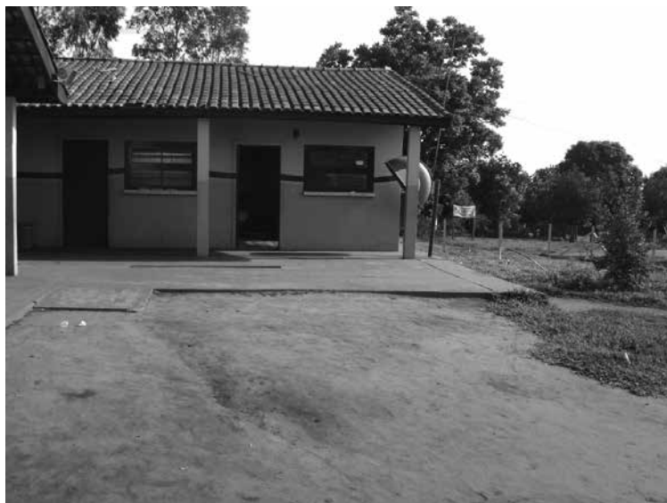
Figura 04 - Vista lateral da escola.
