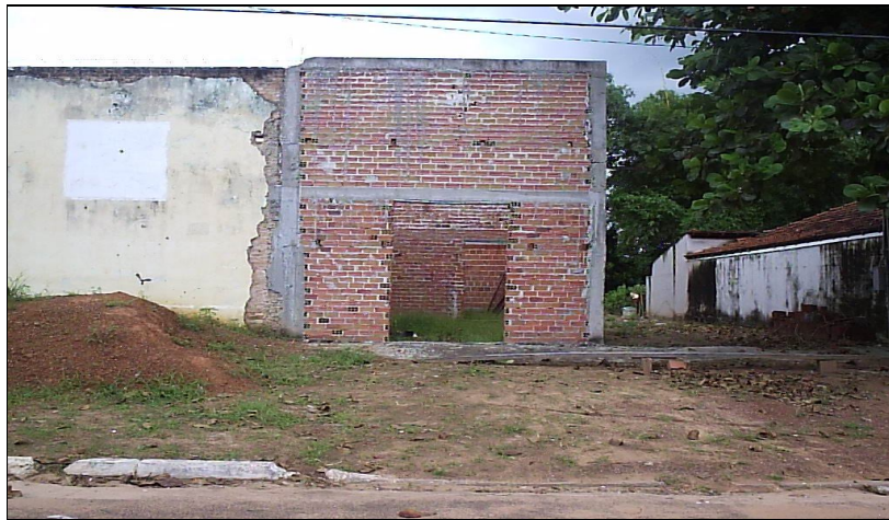
Fotografia 02: Prédio em processo de construção da atual colônia de pesca 4 .
