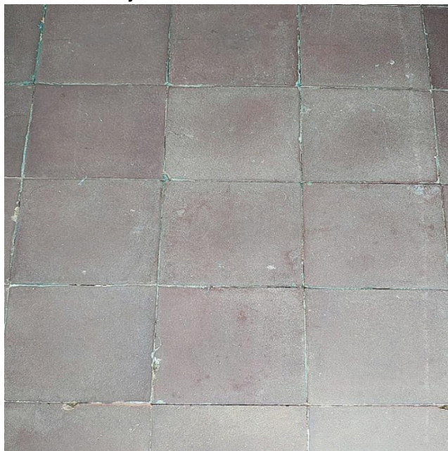
Figura 5 – Piso em lajotas cerâmicas no interior do Casa Borges
