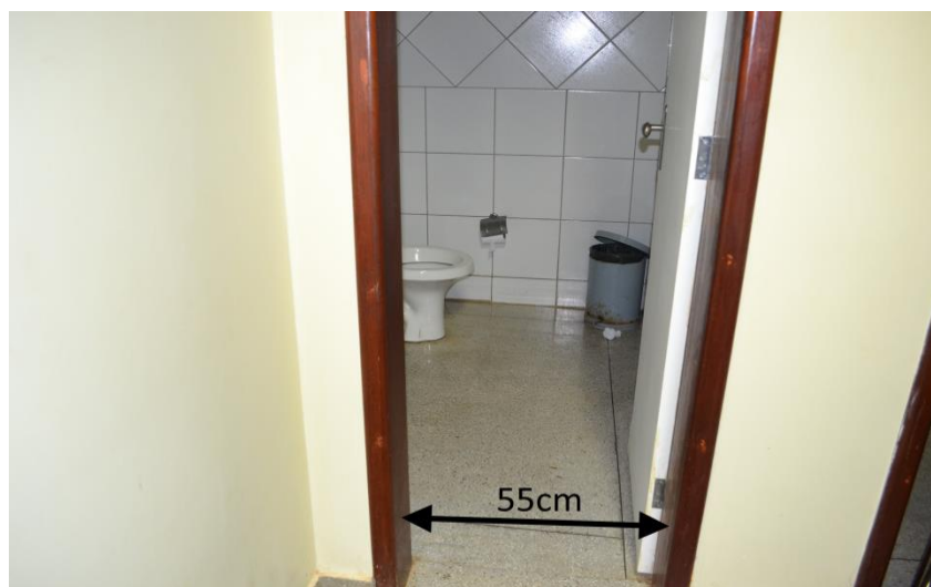
Figura 1 – porta de entrada do banheiro dos servidores
