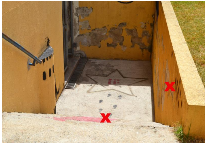
Figura 3 – escadas de acesso à sala de música e artes
