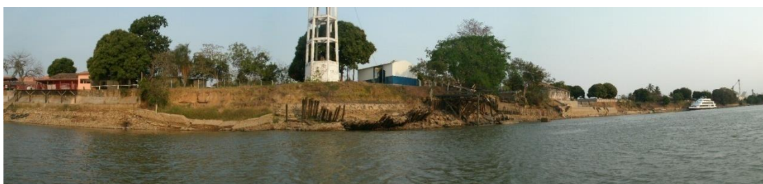
Figura 5: Ponto de captação de água para abastecimento público, período de estiagem
