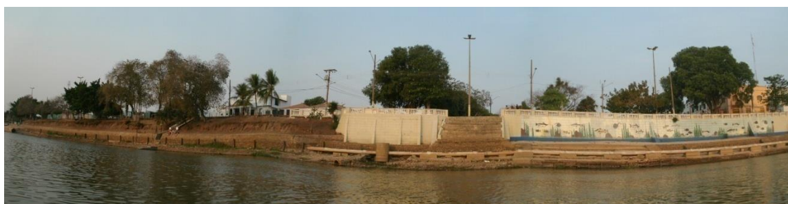
Figura 4: Aspecto geral da margem esquerda Baía do Malheiros, período de estiagem
