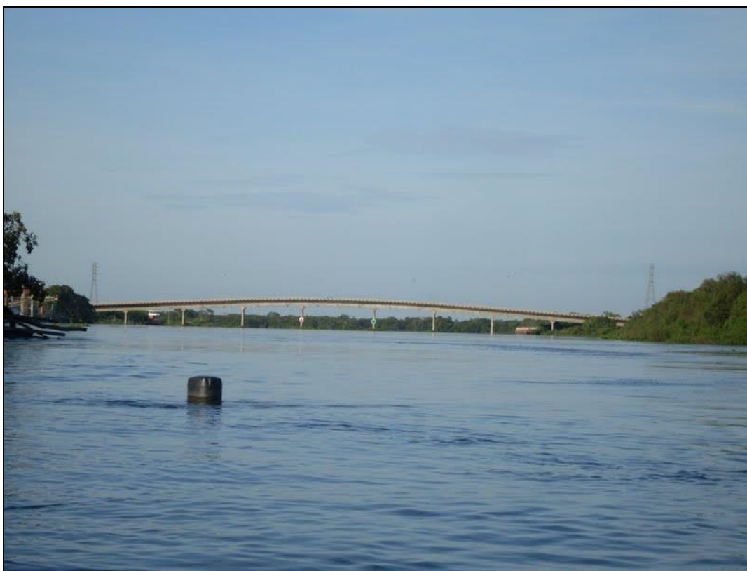
Figura 2: Ponte Marechal Rondon, na cidade de Cáceres
