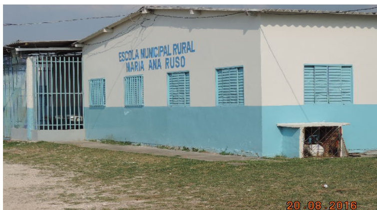
Figura 2. Escola Municipal Rural Maria Ana Ruso, construída no PA-72, Ladário, Mato Grosso do Sul
