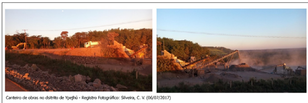
Figura 3. Extração de material para construção da rodovia Ypejhú a Asunción
