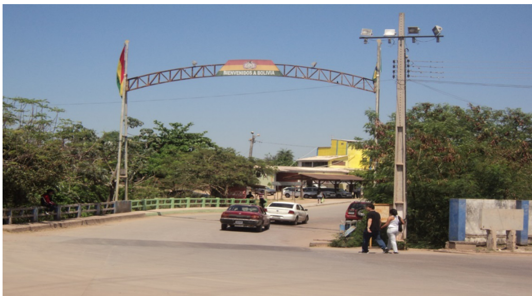
Figura 02 – Ponte sobre Arroio Conceição, fronteira Brasil-Bolívia
