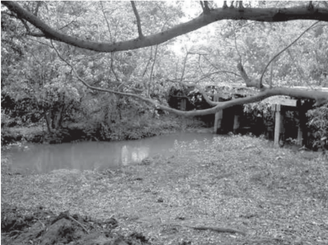
Figura 06 - Ponte sobre o canal do Córrego João Dias. Prolongamento da Rua: 7 de Setembro. Comparando a altura desta ponte com a da Rua Cassimiro Brum e levando-se mais próximo que ela é a que está mais próximo com a confluência no Rio Aquidauana, deveria contribuir com mais vãos de passagem das águas das cheias.
