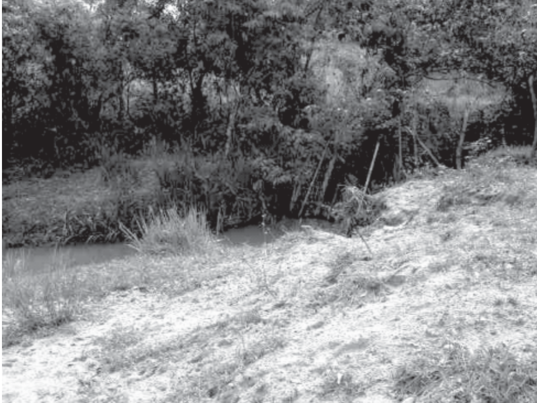
Figura 01 - Canal do C. João Dias a jusante da estrada BR-419. A margem esquerda define evolução típica de atividade erosiva combinada com solo inconsistente.
