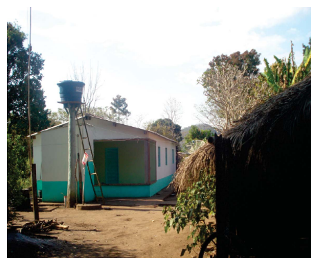
Figura 2. Residência no Assentamento Sumatra.
