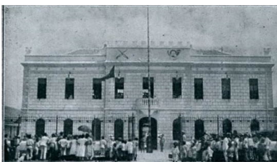
instalação da OM
