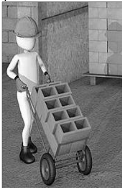
FIG. 6 – Transporte adequado de blocos cerâmicos [17]
