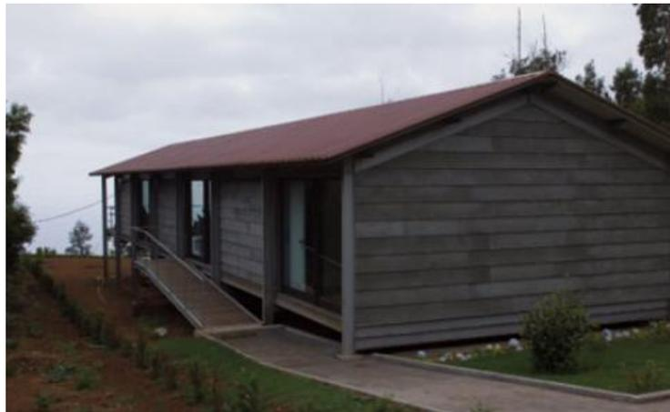
FIG 14 – Painéis cimento-madeira confeccionados a partir de resíduos de madeira e utilizados na construção civil (figura adaptada)<sup>15</sup>.
